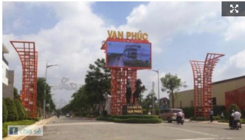
Hàng loạt công trình chưa được cấp phép đã được chủ đầu tư xây dựng trong Khu đô thị Vạn Phúc
